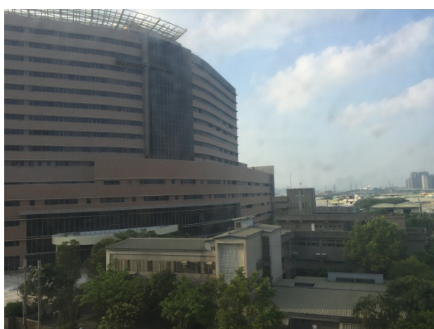
新しく建設された 輔仁 大学病院（夏から始動）
