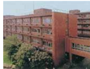
基礎研究棟(手前)
