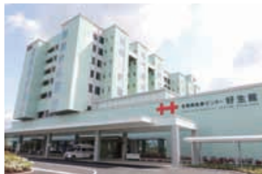
地方独立行政法人佐賀県医療センター好生館 SAGA-KEN MEDICAL CENTRE KOSEIKAN
