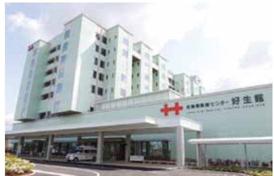
地方独立行政法人佐賀県医療センター好生館 SAGA-KEN MEDICAL CENTRE KOSEIKAN
