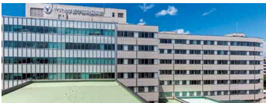
東病棟 | East Ward
