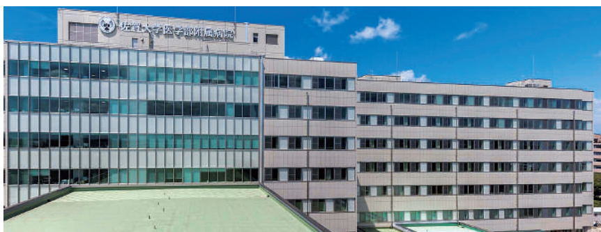
東病棟 | East Ward
